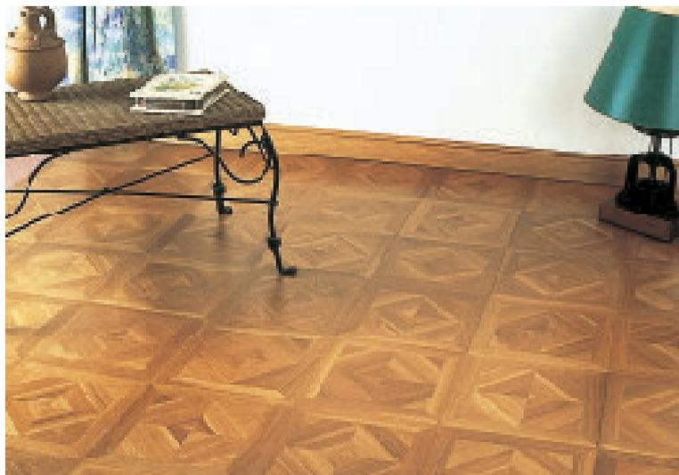
La technique de pose d'un parquet flottant en dalles est assez proche de celle d'un parquet flottant en lames (Voir pages précédentes). Par leur forme carrée, les dalles permettent soit une pose parallèle aux murs de la pièce, soit une pose en diagonale ; cette dernière étant plus délicate à cause des coupes périphériques en biais.
