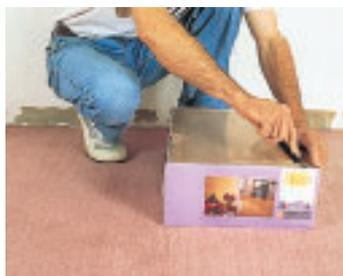
On pose la première rangée de dalles côté rainure, le long d'un mur droit, en plaçant entre le mur et la dalle des cales de jeu. Prévoir deux cales pour chaque dalle dont un côté est en appui contre le mur ; ainsi la dalle d'angle est en appui sur quatre cales.
