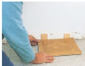
1. Ouvrir les paquets de dalles au moment de la pose (ils étaient stockés à plat dans un endroit sec).
