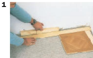
Il est fréquent dans les maisons anciennes qu'aucun mur ne soit suffisamment droit pour servir d'appui. Placer des règles ou des planches parfaitement droites et à bords parallèles (par exemple des plinthes) contre deux murs en angle, et les caler pour qu'elles forment un angle droit.
