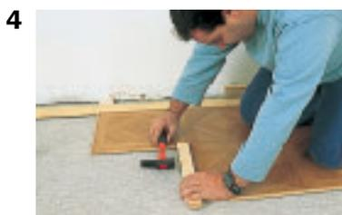
**1. Poser la première dalle à l'angle des deux règles, rainures côté mur.**
